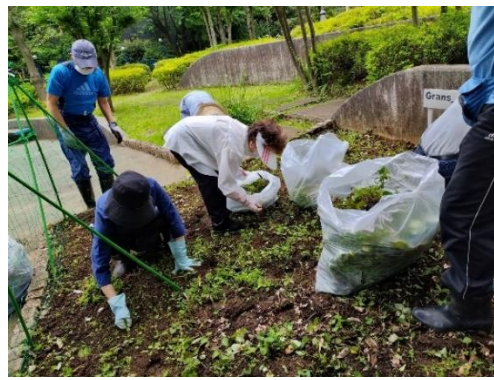
③ 皆で整地作業
